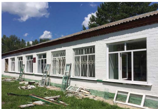
Ремонт здания подшефной школы
